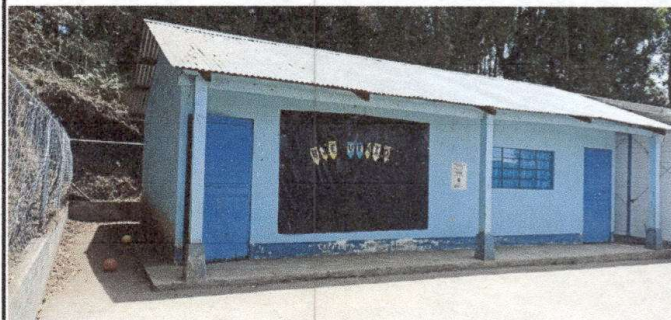
Foto 4: Pintura interiores y exteriores
