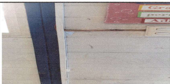
Foto 5: sustitución de cableado eléctrico
