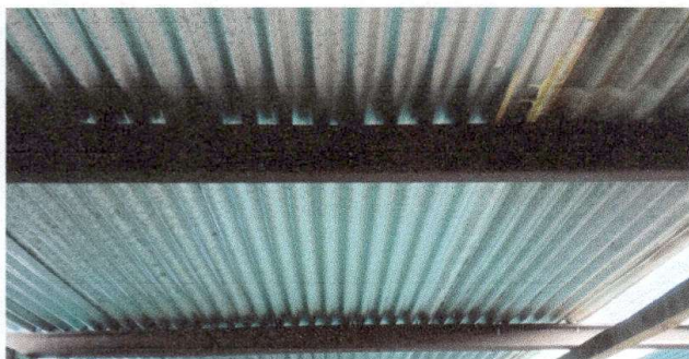
Foto1: Sustitución de soporte de metal por metal
