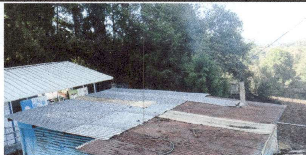
Foto 2: sustitucion de lamina por lamina troquelada calibre 26
