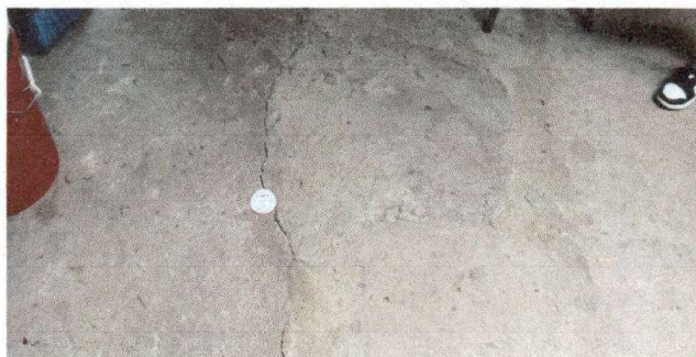
Foto 3: sustitucion de torta de concreto
